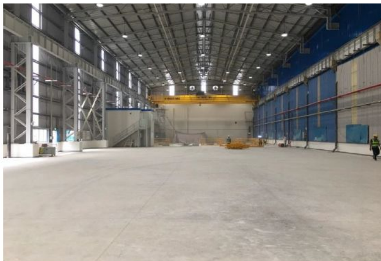
SUNSCO 第2冷延ミル建建屋(建設中)
