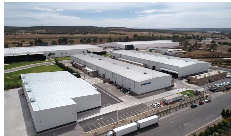
切断工場（2019年4月完成）
