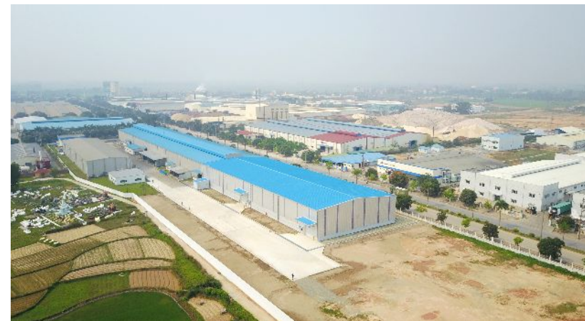
Maruichi Sun Steel (Hanoi) Company Limited 製品倉庫 (2018年3月完成)
