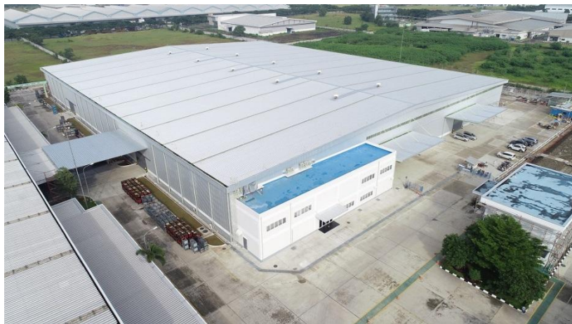
ジャカルタ東部 チカラン工場 (2019年3月新工場建屋完成)
