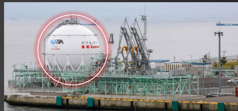
国内最大の液化水素貯蔵タンク
