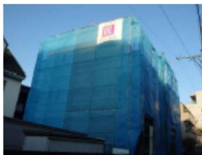
施工現場での定期的な 安全パトロール実施
