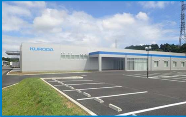
かずさアゲミ工場新棟
