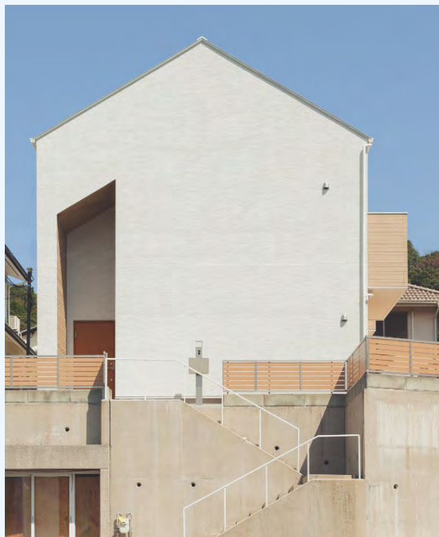
<建築家とのフルリノベ事例>
