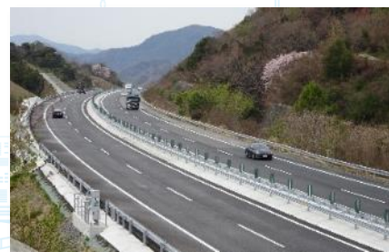
高松自動車道 鳴門舗装工事
