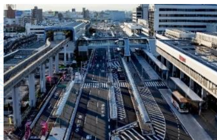
大阪国際空港 アクセス道路改良工事
