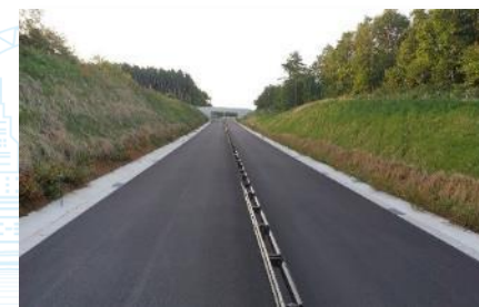
侍浜地区舗装工事
