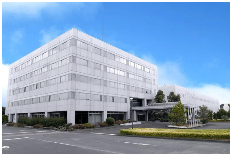
掛川センター
