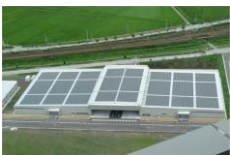
太陽光第二発電所
