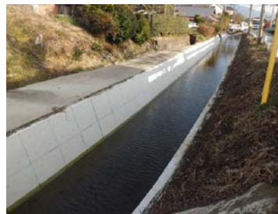
(高耐久性レジンコンクリートパネル によるライニング施工後)
