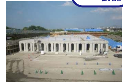
地下 雨水貯留施設
