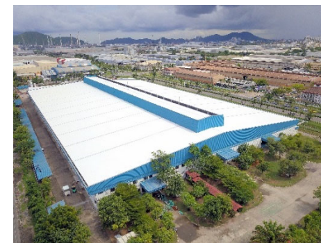
稼働を開始したタイ第二工場
