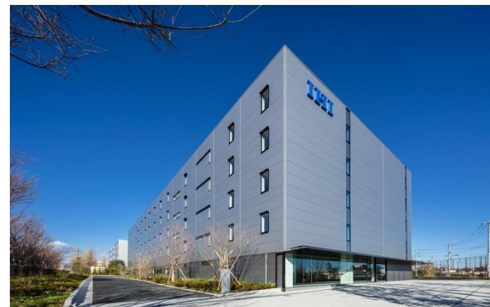
<昭島新事務所棟>
