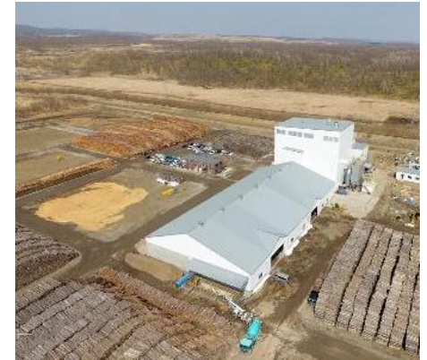
自社木質バイオマス発電所
