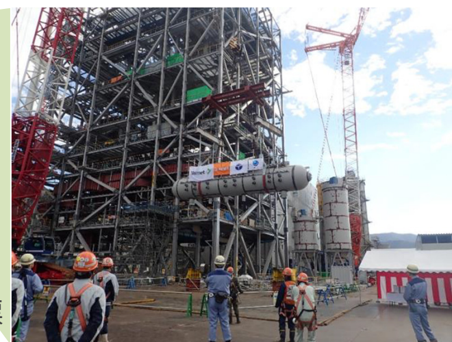
大船渡発電所蒸気ドラム上架式 (2018/10月)
