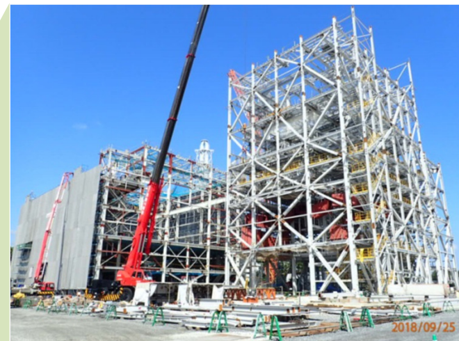
大船渡発電所蒸気ドラム上架式 (2018/10月)
