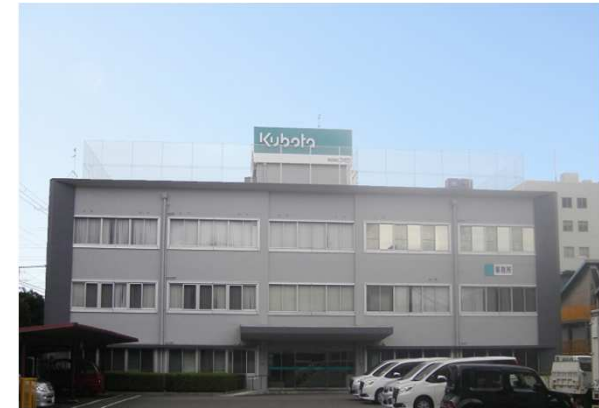
堺製造所耐震改修
