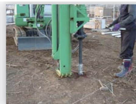
④ 打ち込み完了。 固定ピンを抜き駆動軸を 抜き取る。
