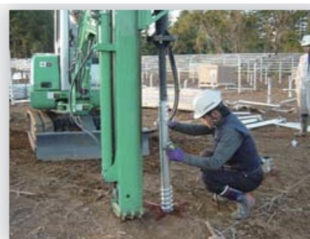
③ 杭の打ち込み中間位置にて 再度レベル確認。
