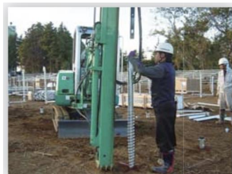
① ドリルマストを接地し、 駆動軸を杭に挿入。 ピン等で固定。
