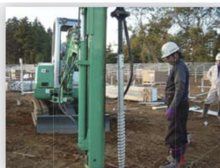
② 水平機を使用して杭の レベル確認。 微調整を行ったあと、 打ち込み開始。
