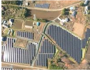
S-19 LS桜川下泉発電所
