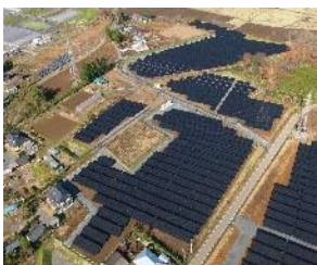
S-19 LS桜川下泉発電所
