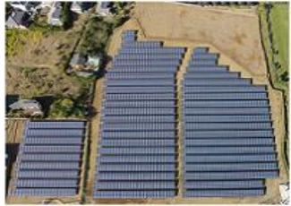
S-11 LS神栖波崎発電所
