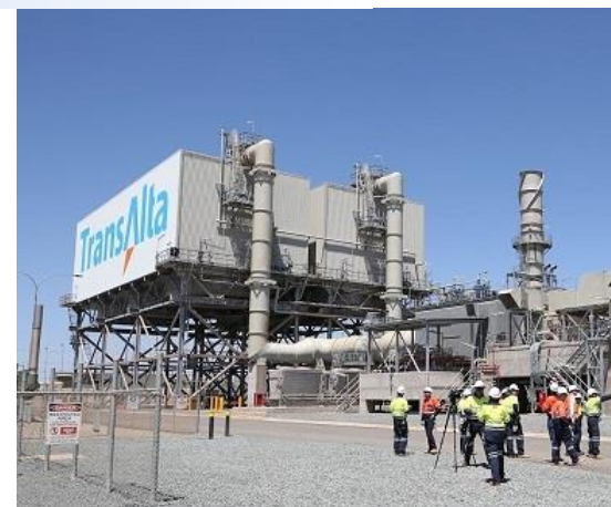
<「LM6000」発電設備 >
