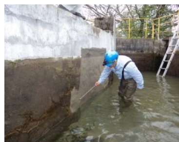
[湿潤面補修材 試験施工] 東長原(旭ダム系水路)；壁面漏水補修
