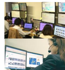
融雪システム監視 (冬期間24時間)
