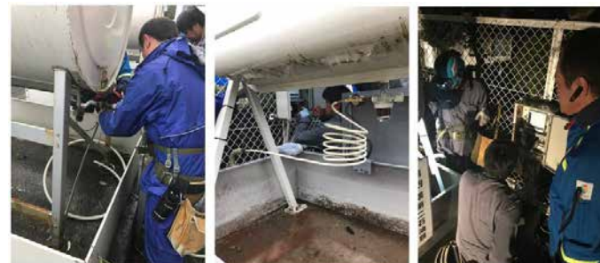
協業による灯油タンク残量監視ソリューションの施工模様
