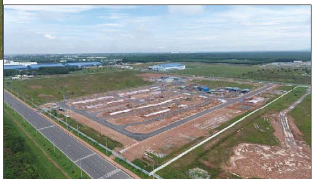
第2工場第1期建設工事
