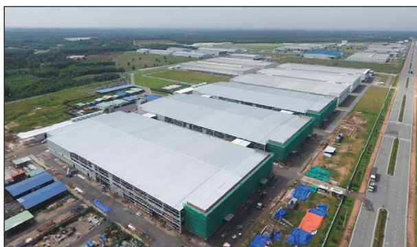
第1工場第2期建設工事
