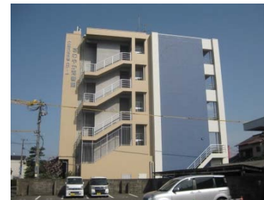
<施設側面部(施工後)>
