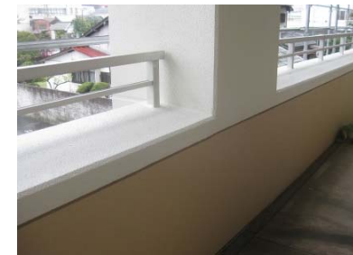
<手摺壁(施工後)>
