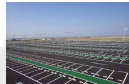
関西国際空港整備工事
