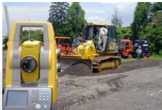
ICT施工状況
