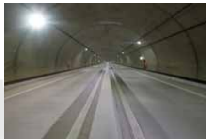
楯這トンネル舗装工事
