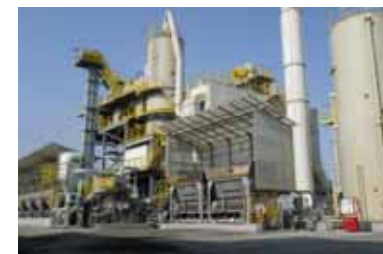
倉敷合材工場
