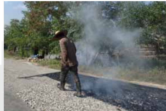
ミャンマーでの施工状況
