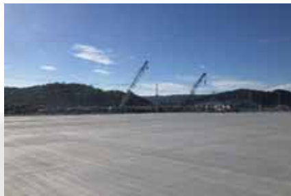
宮古港舗装復旧工事
