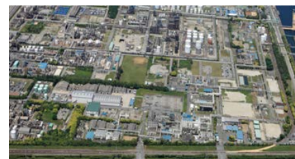
千葉工場全景
