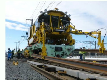
東北新幹線レール交換
