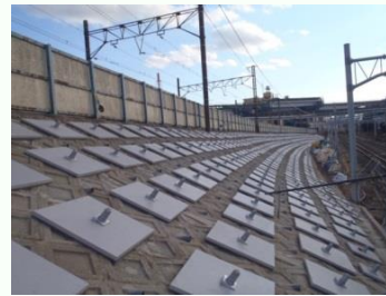
耐震補強対策
