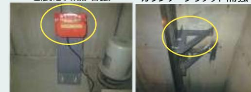
巻き上機モーター更新      制御盤更新
