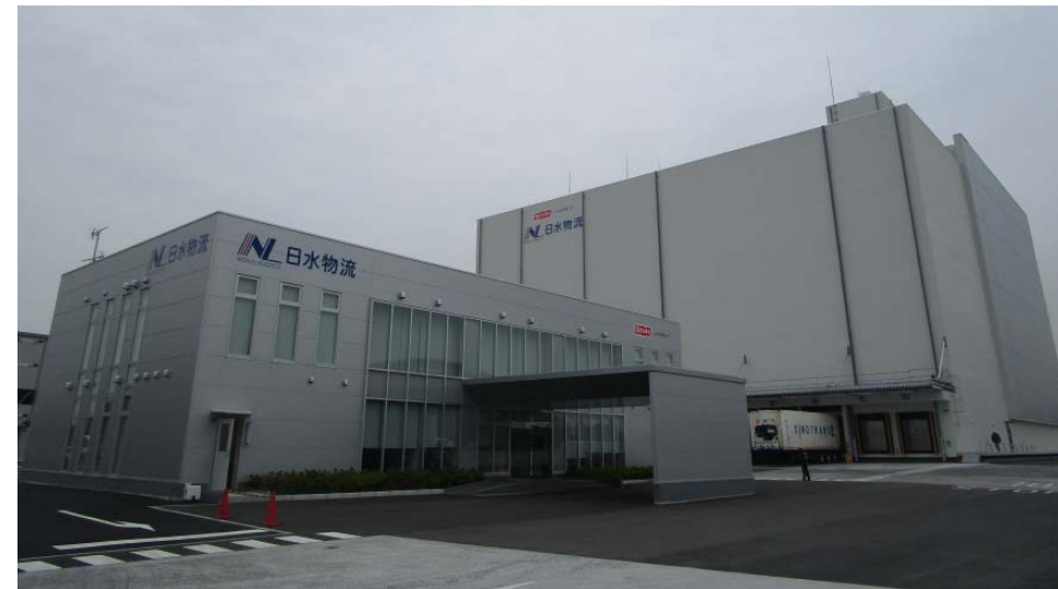
日水物流・大阪舞洲物流センター(設備能力:約25,400トン) 2016年3月竣工、同4月より営業開始
