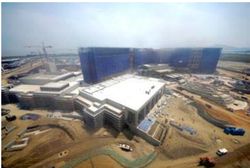
<工事進捗 (2016年6月29日時点)>
