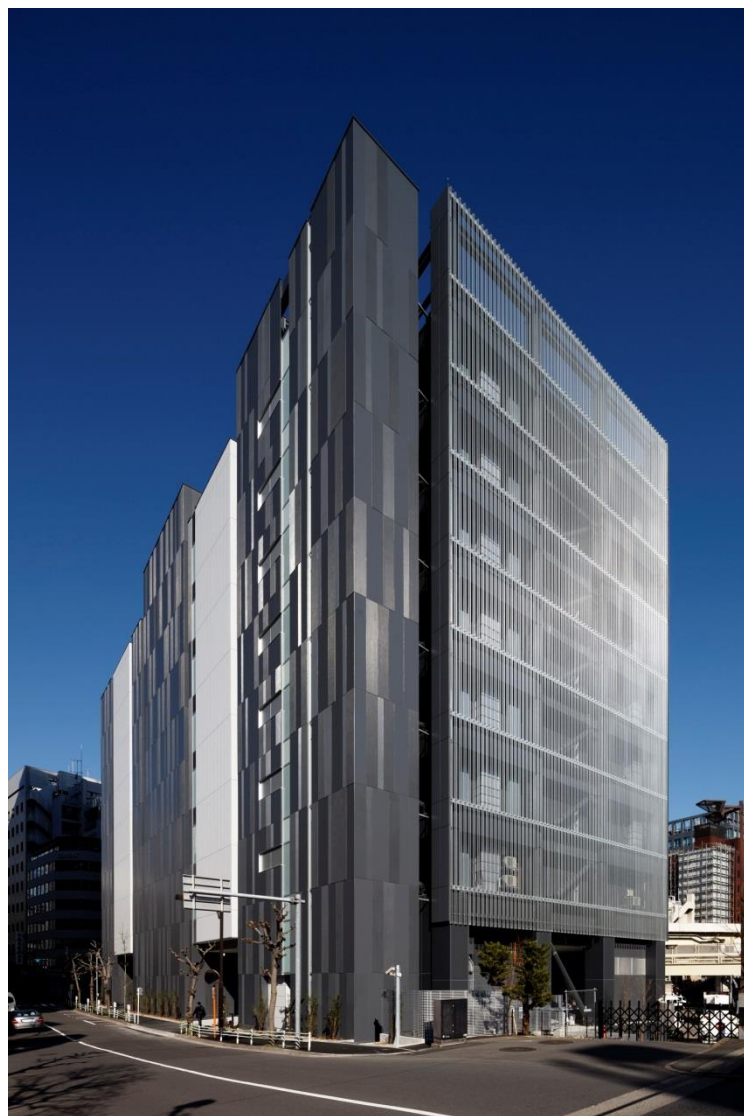
写真：エスエス東京支店
