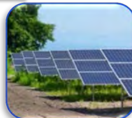
太陽光パネル設置
