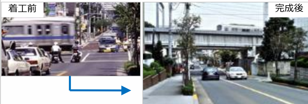
踏切の廃止（経堂～千歳船橋間）
