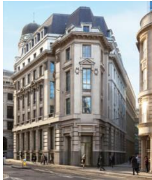
リニューアル工事後の竣工イメージ
