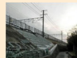
斜面防災対策
