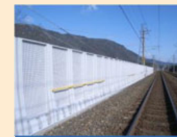
防風柵の整備
