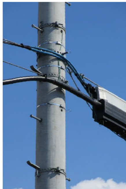
(施工例)電話関連金具
