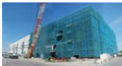
四日市工場 第5製造棟 第2期建設
