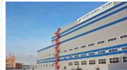
東芝パワーマシーン 変圧器社(ロシア)
