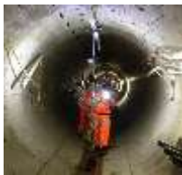
トンネル検査
