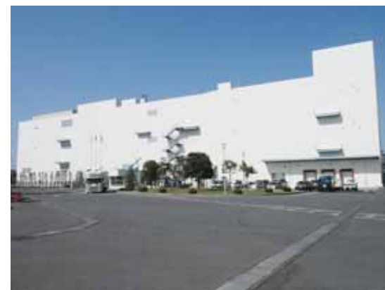
(写真) 日本ハムファクトリー 茨城工場 新棟
