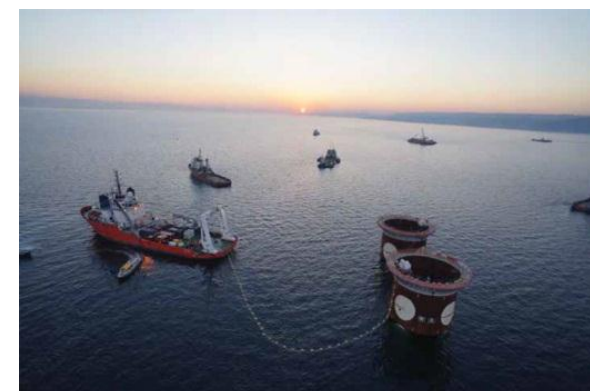
主塔基礎ケーソンの海中への沈設
