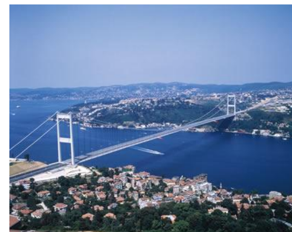
補修工事を受注した 第2ボスポラス橋
