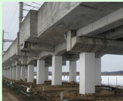
高架橋柱耐震補強
