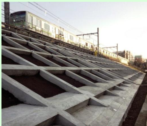
盛土耐震補強
