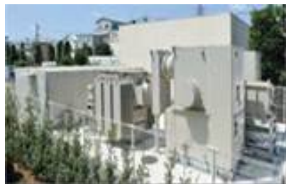
特高受変電設備
