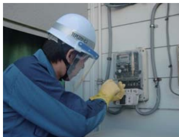
計器失効替工事
