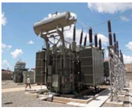
プラント施工
