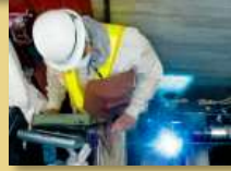
高圧幹線工事
