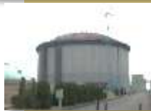
泉北製造所 第1工場5号タンク
