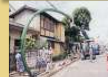
ガス導管の 耐震化対策
