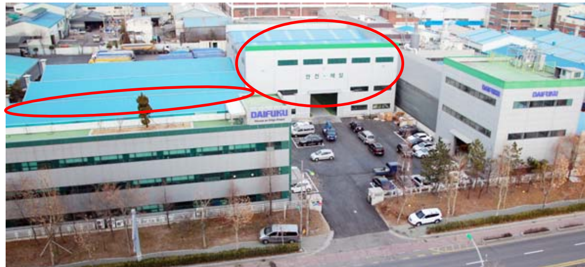
Daifuku Korea Co., Ltd. (丸囲みが増改築箇所)
