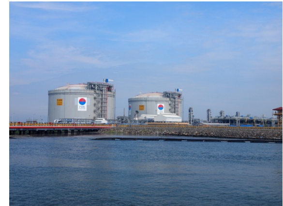
当社が2012年Petronet LNG社に納入したコチLNG受入基地向けLNG貯蔵タンク
