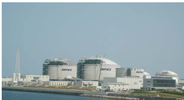
直江津 LNG 基地
