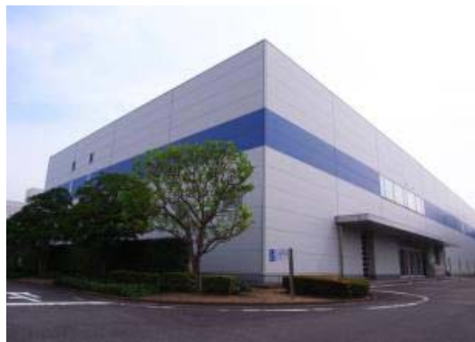
CMO静岡工場 (治験薬棟)
