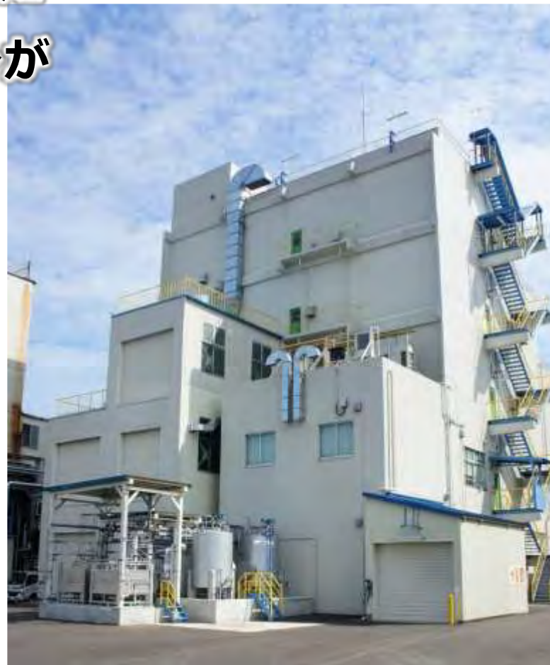
新井工場 機能化学品製造設備
