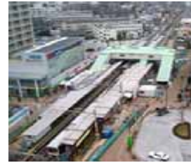
地下化切替前の駅舎
