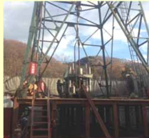
ボーリング工事中
