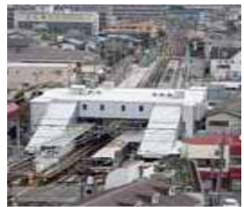
地下化切替前の駅舎
