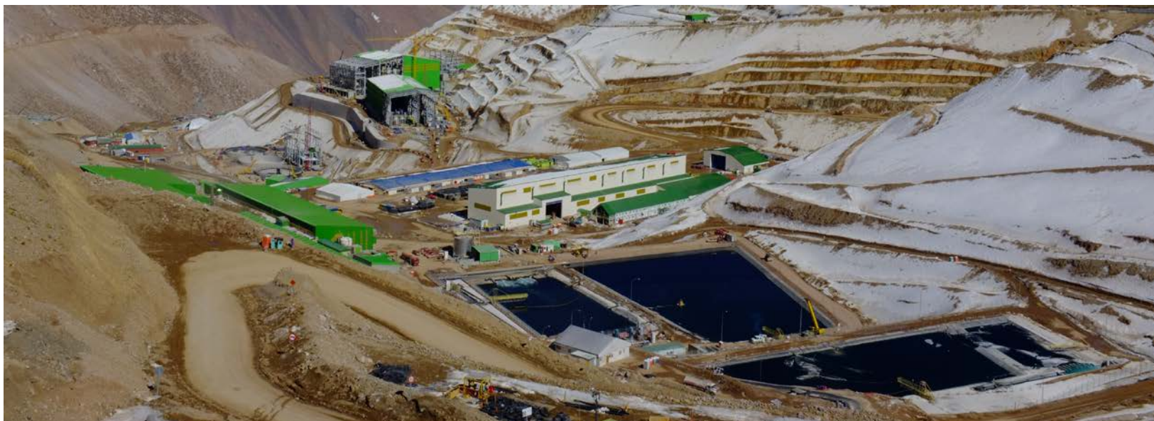
設備全景 (SXEW 工場、採鉱機械修理場 (トラックショップ)、選鉱場 (磨鉱・浮選建屋))
